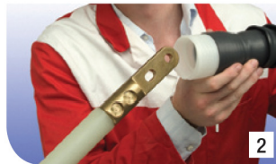
2 Tempatkan body terminasi 3M Coldshrink pada ujung kabel dengan tepat
