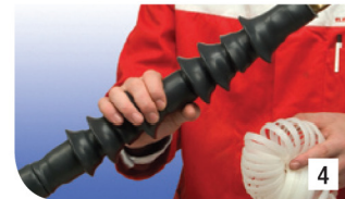
4 Proses instalasi terminasi sudah selesai
